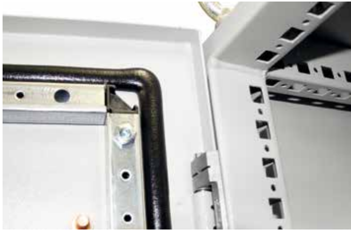
Dichtungsschaum für einen elektronischen Schaltschrank
